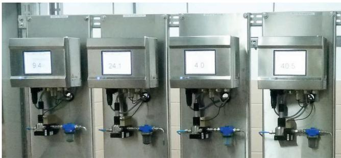
Sensori di ossigeno montati su un pannello nel ciclo acqua-vapore
