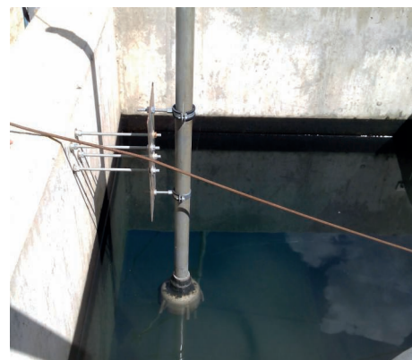
Sensore SONATAX sc sopra la vasca di raccolta dei fanghi.
