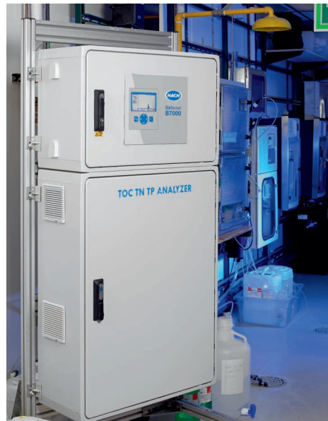
Analizzatore di TOC Biotector B7000
