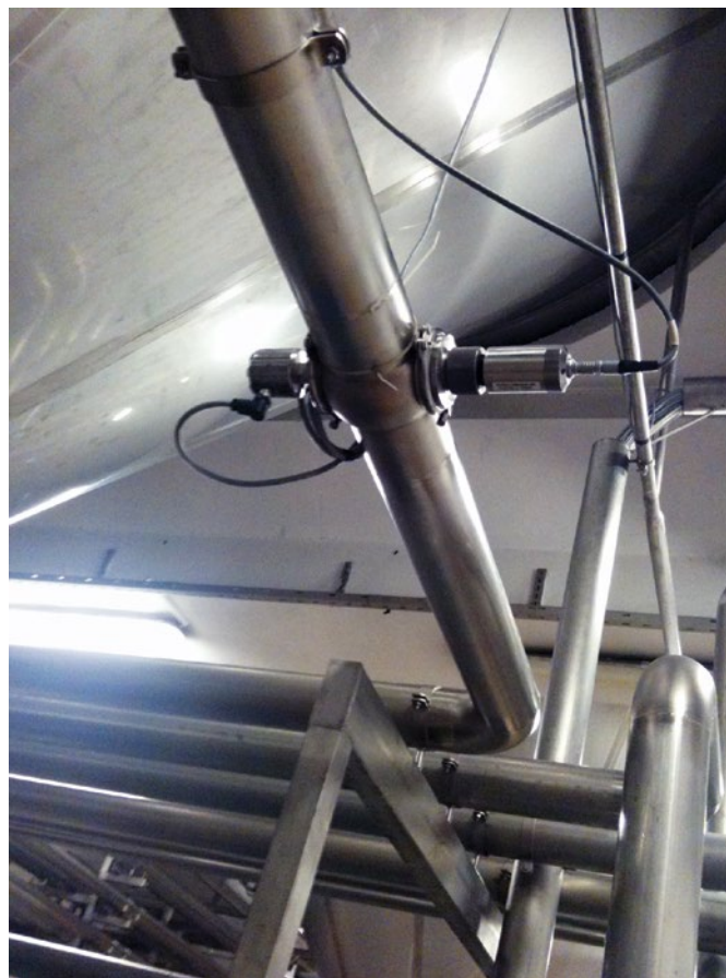
Figura 3. Sensore M1100-H LDO di Hach – installazione tipica
