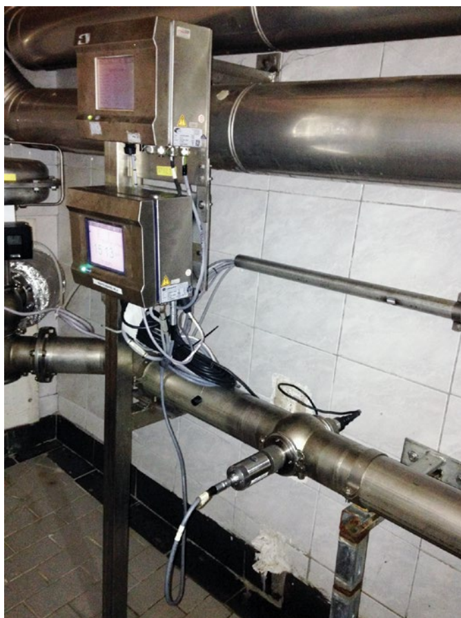
Figura 2. Controller 410 di Hach – installazione tipica
