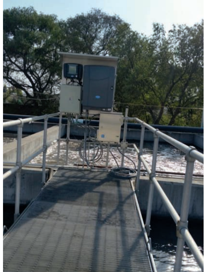
Fig. 7. Sistema RTC-P installato e in funzione
